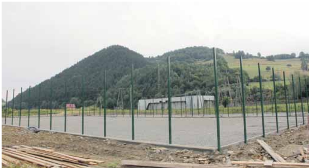
Budowa boisk wielofunkcyjnych przy basenach
