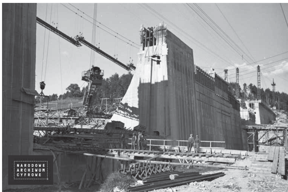
1939r. Trwa budowa zapory
