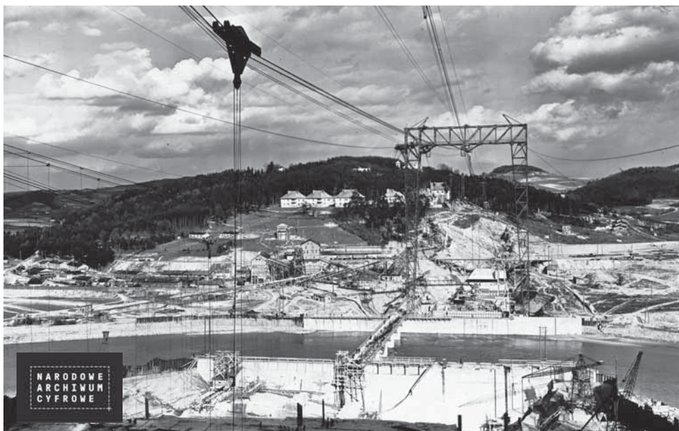
1938r. Budowa zapory w Rożnowie
